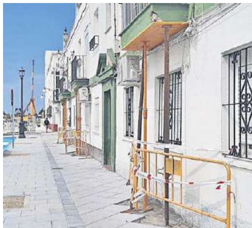
Una de las viviendas apuntaladas en la avenida de la Bajamar.
