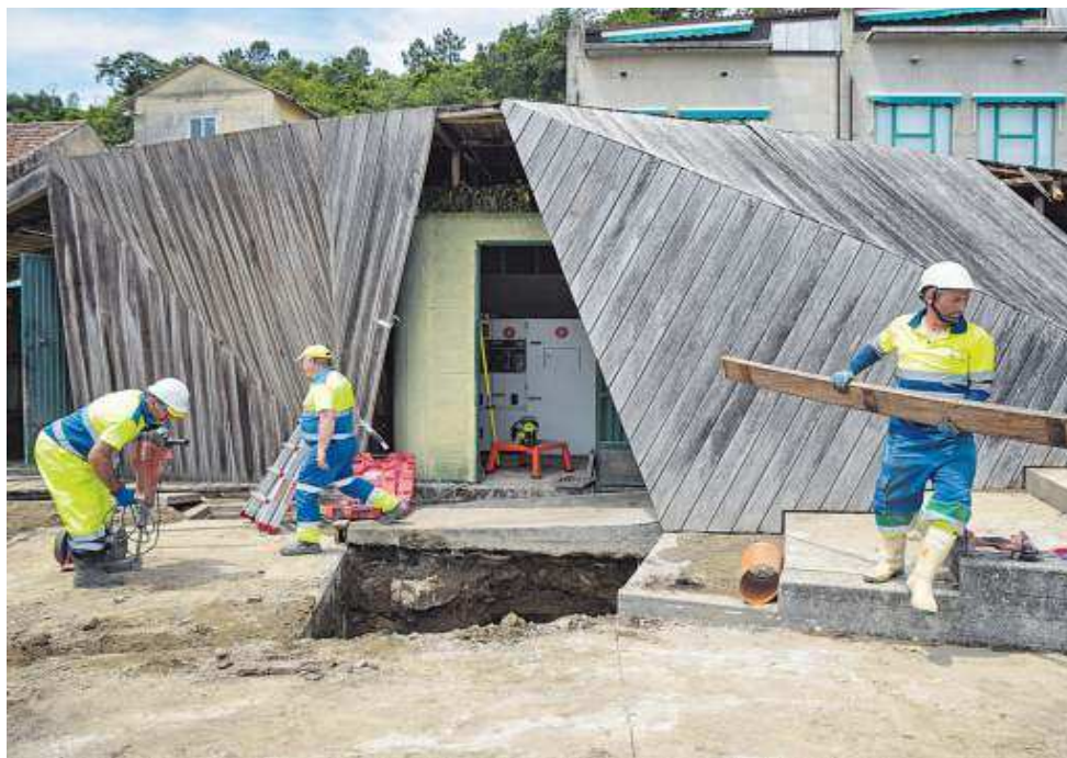
Tareas de reparación de la avería en el bombeo llevadas a cabo ayer en el puerto de Beluso. ADRIÁN BAÚLDE
